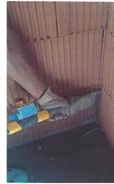
Fig. 6:Realiseren verticale voegen
