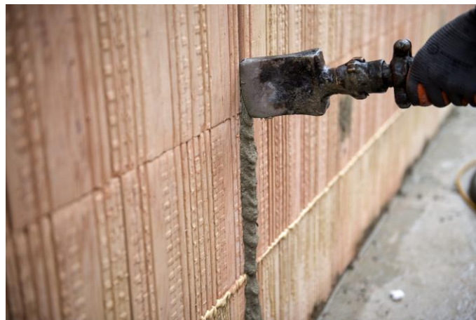
Fig. 6:Realiseren verticale voegen
